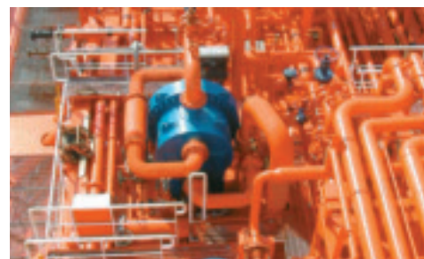
4800 кВт, нагреватель сжиженного природного газа установлен на судне, тип 9 LL - 222/1/1 с титановыми пластинами.
